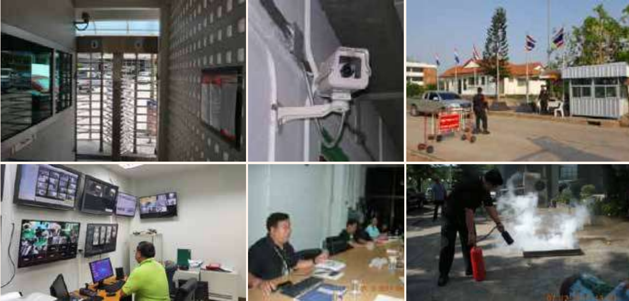
ภาพแสดงระบบรักษาความปลอดภัย 24 ชั่วโมง และระบบบันทึก CCTV ระบบการเข้า-ออก Access Control
